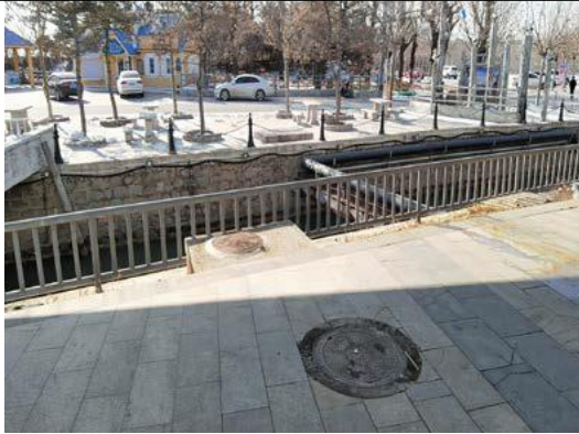
隔油池+化粪池
